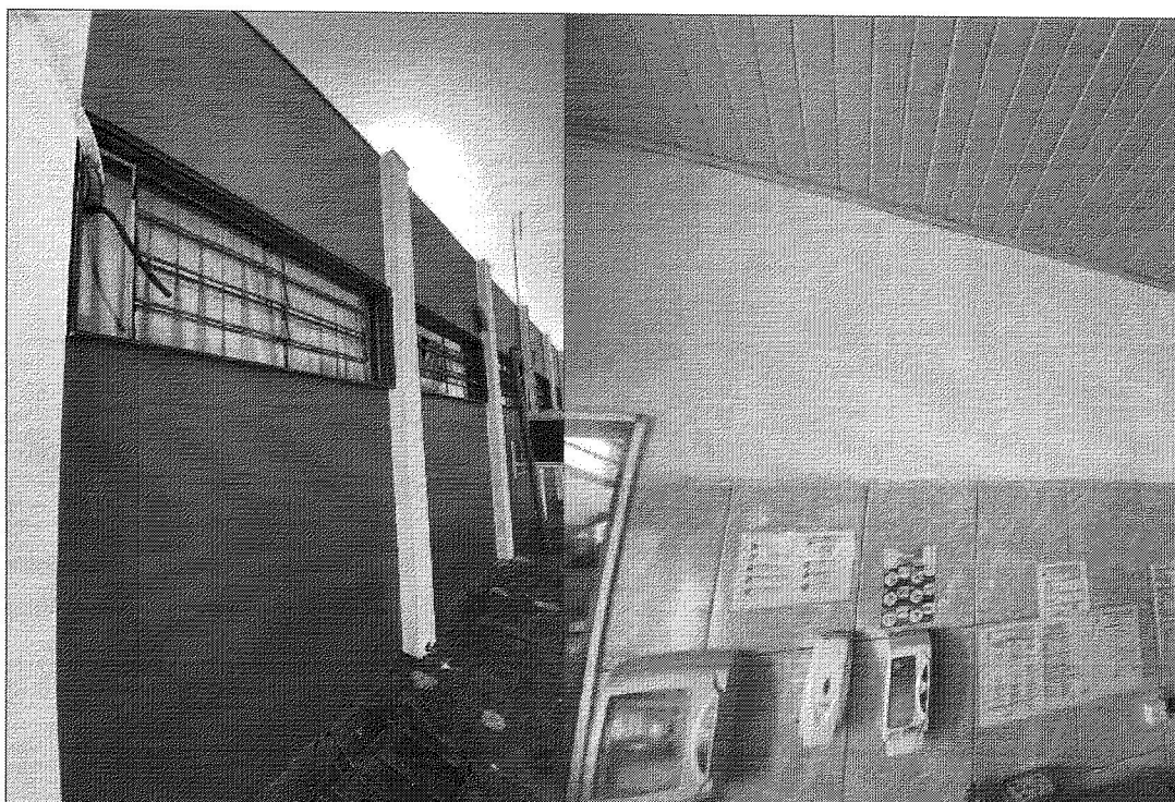
BLOCO D - LATERAL DIREITA
